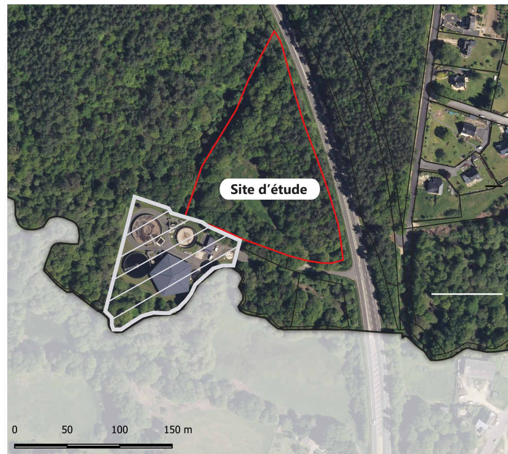
Localisation de la station d'épuration
