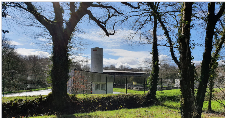
Vue sur la station d'épuration du site d'étude - Source : Prigent&Associés
